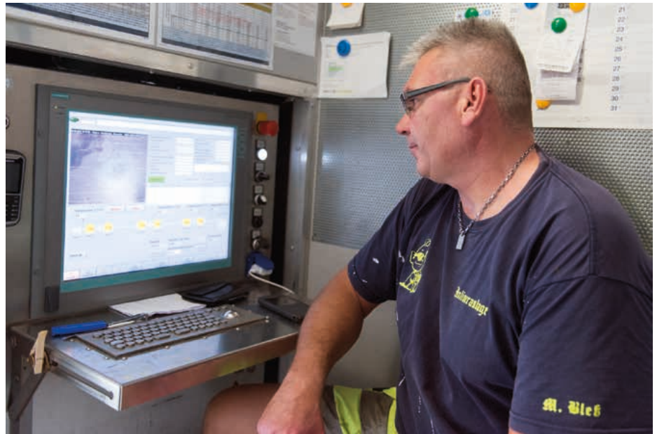
Mario Bleß (U&W) bei der Überwachung der Aushärtung im Sanierungsfahrzeug
