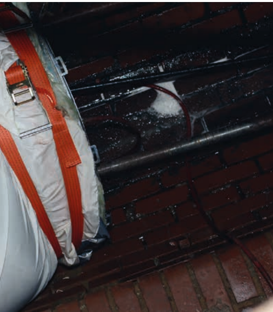
Packer-Verbau im Schacht
