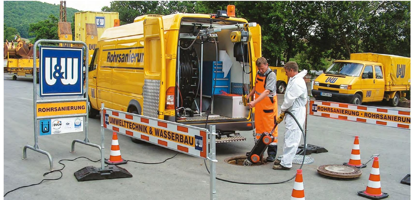
Rohrsanierungstechnik mit Spachtel- und Fräsrobotern DN 150-600
