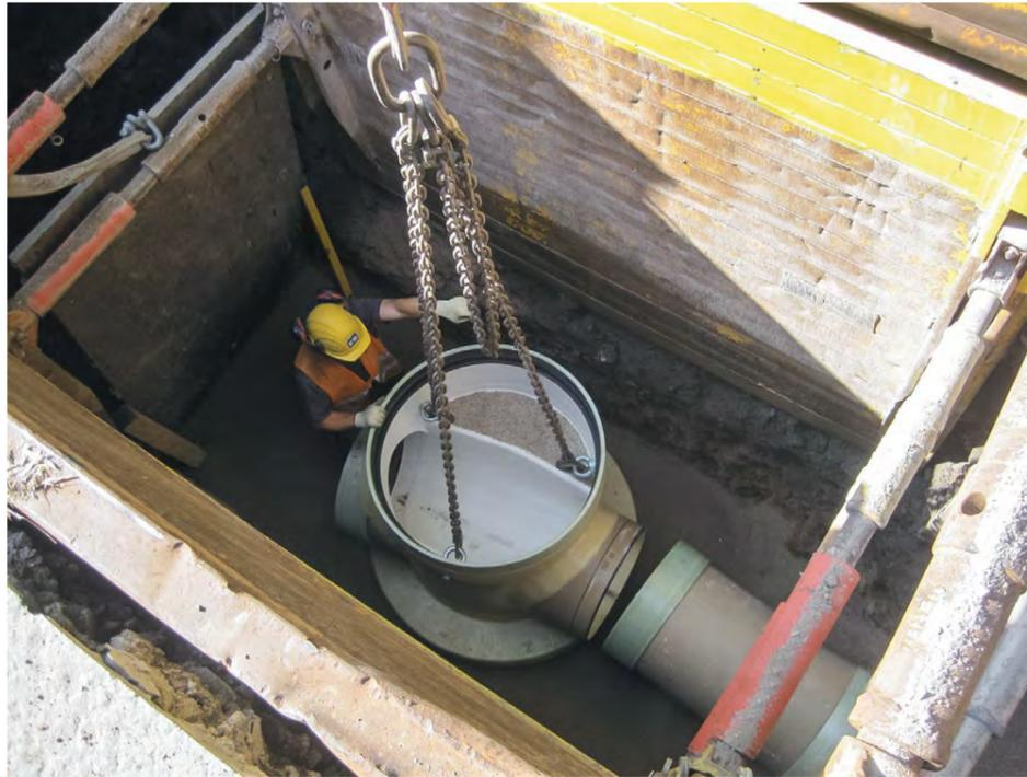
Schachtbaugrube GFK DN 600 Clausthal-Zellerfeld
