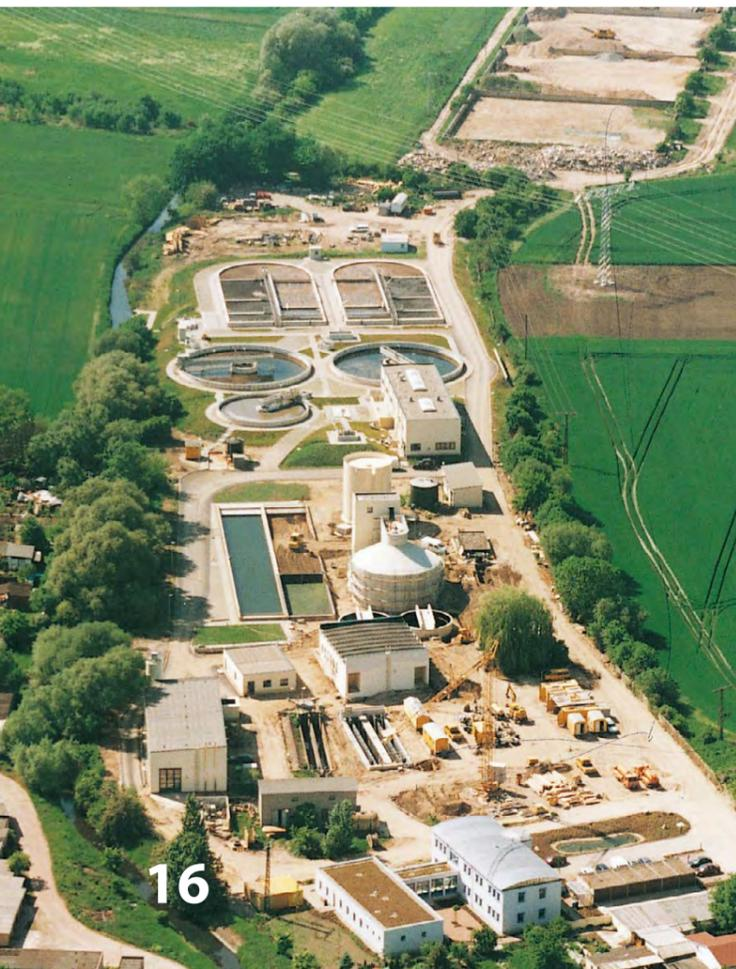
*Grubenwasserreinigungsanlage 45–60 m<sup>3</sup>/min in Schleenhain*
