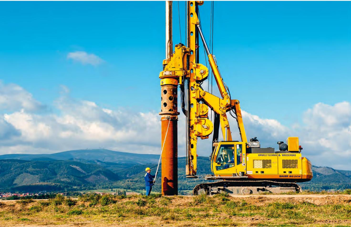
Deponie Wernigerode – Großdrehbohrgerät BG 24
