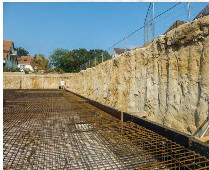
Baugrube in Wustrow – Baugrubenumschließung mittels Bodenmischverfahren
