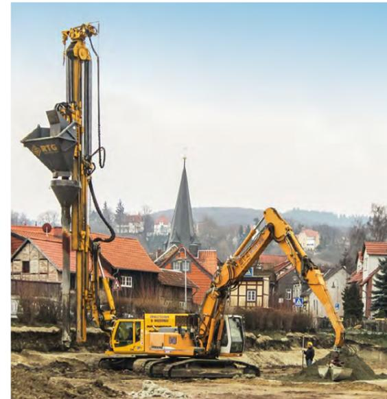
Wernigerode, Rüttelstopfverdichtung für die Gründung der Zindel-Turnhalle
