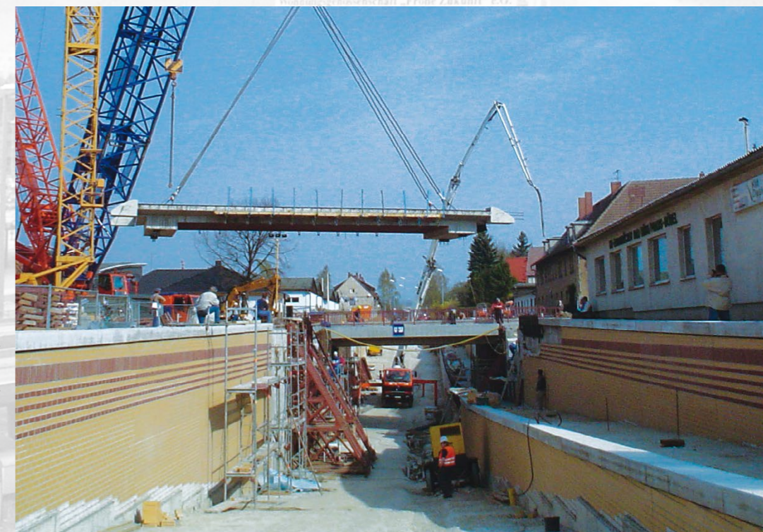
Brückenmontage am Veckenstedter Weg in Wernigerode
