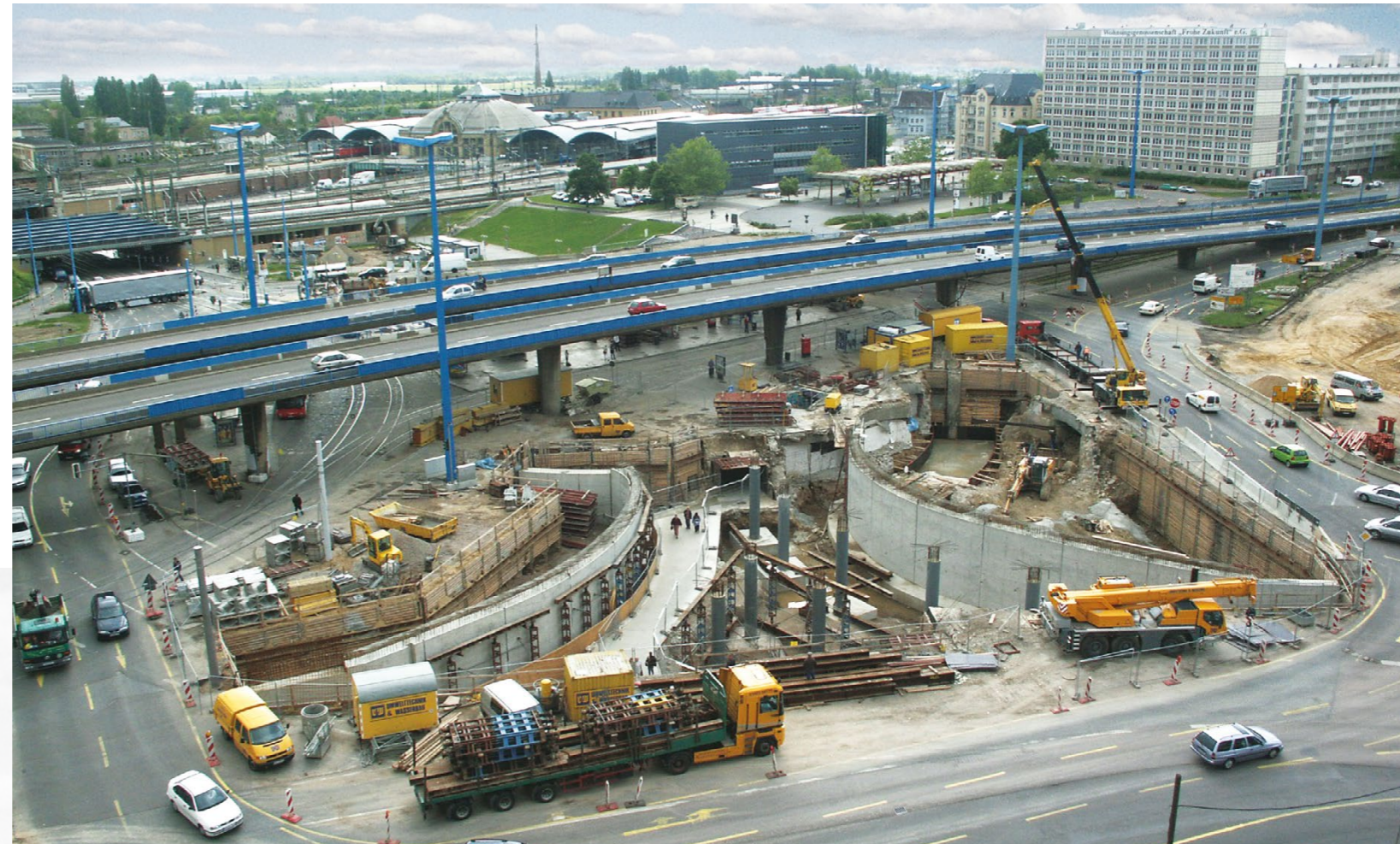
Großbaustelle Riebeckplatz in Halle
