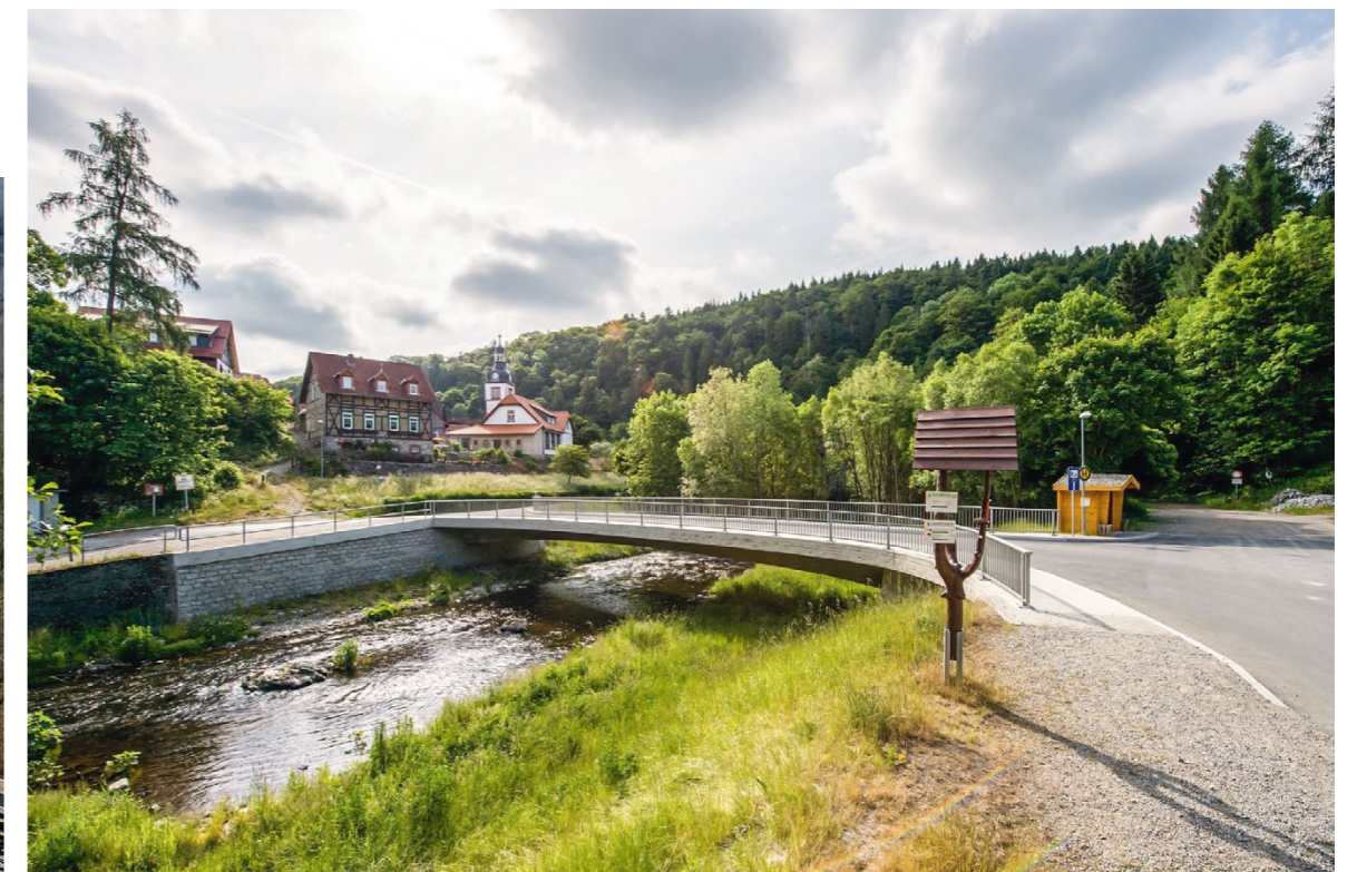
Brücke über die Bode Neuwerk
