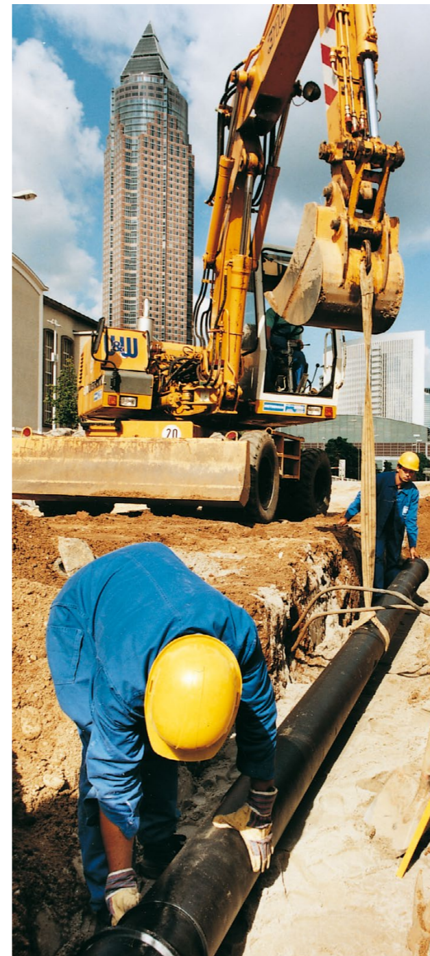
Abb. oben: Wasserleitungsverlegung in Frankfurt am Main
