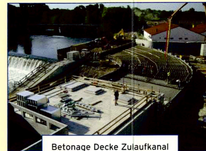
Betonage Decke Zulaufkanal Juni 2008
